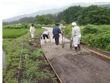
(下須賀川地区での作業の様子)
