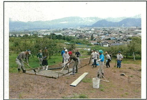
【農道舗装の様子】
