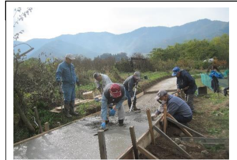
【農道舗装の様子】
