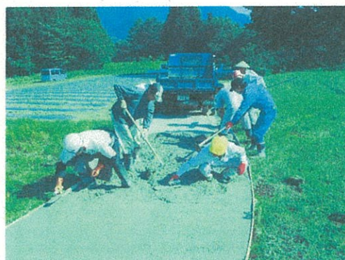
【農道の舗装作業】
