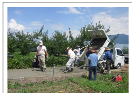
【農道舗装の様子】
