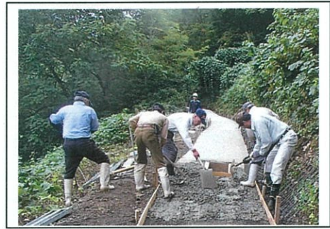
【住民による舗装作業の状況】
