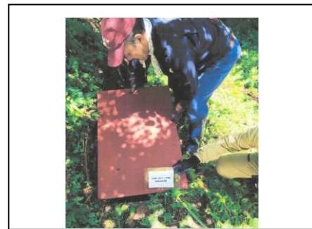
【縞鋼板敷設状況】
