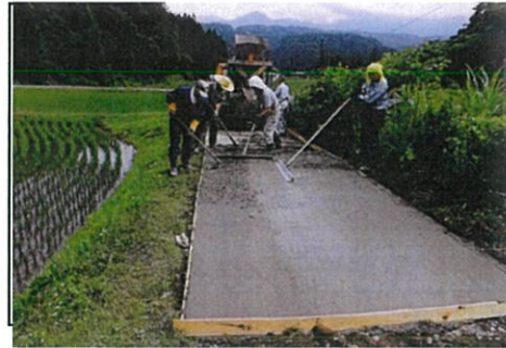
【生コン打設状況】
