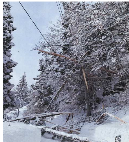
令和2年12月降雪による被害状況(栄村)
