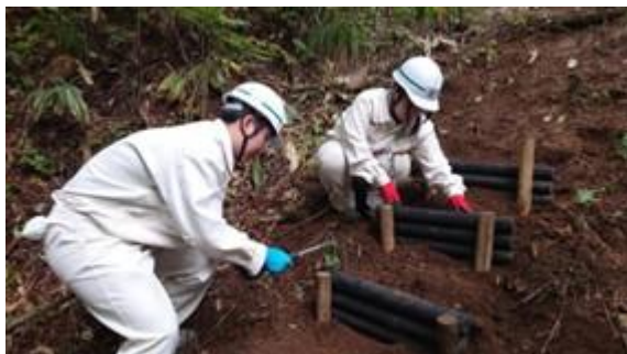
歩道の整備状況
