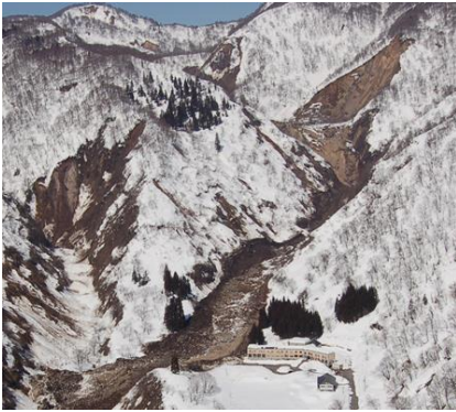
[栄村中条川 災害発生直後の状況]
