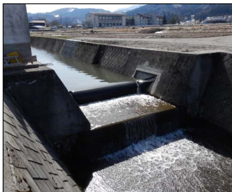
安定した用水供給を行う頭首工
