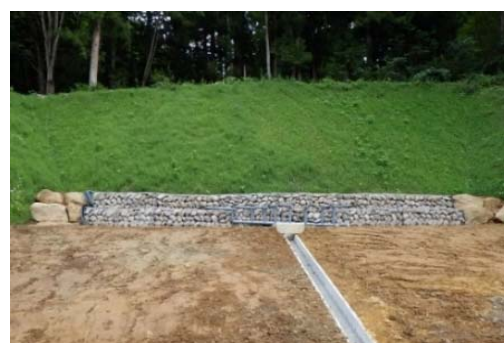
32 地下水排除により地すべりを防止(上境地区)
