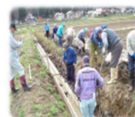
飯山市上野青空会 地域住民が排水路を補修
