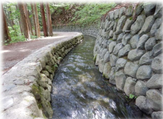
周辺の景観に配慮された坪根堰(山ノ内町)
