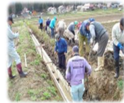
飯山市上野青空会 地域住民が排水路を補修
