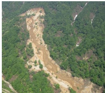
[飯山市井出川 災害発生直後の状況]
