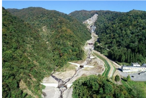
[栄村中条川 治山事業実施状況]
