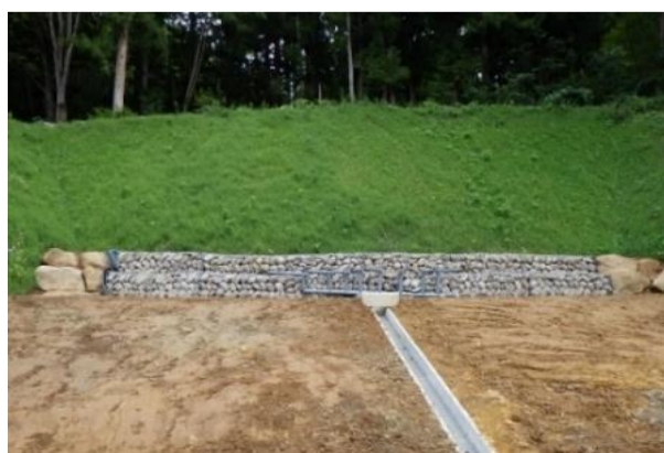
地下水排除により地すべりを防止（上境地区）
