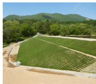
【耐震化が完了したため池（永田地区 大池）】
