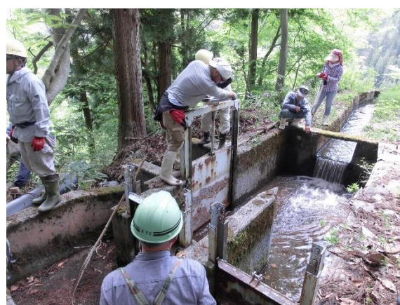
分水ゲートの点検
