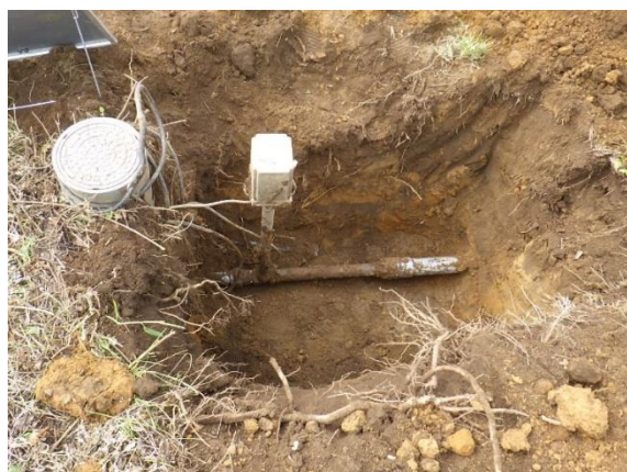
電動弁 (更新前)
