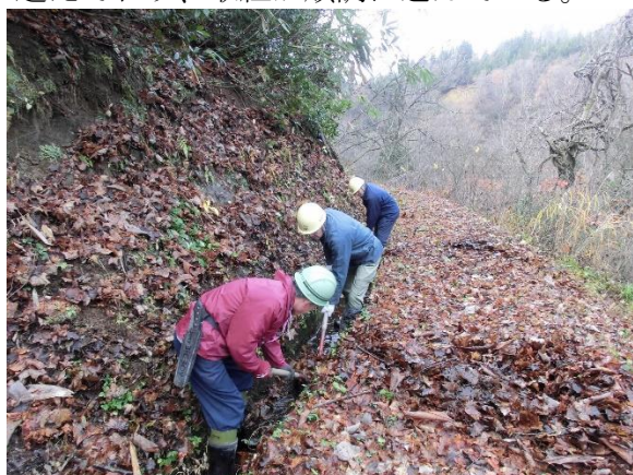
山腹水路の土砂上げ
