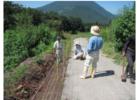
【獣害対策としての電気柵設置】
