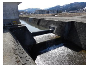
【飯山中部地区の頭首工】
