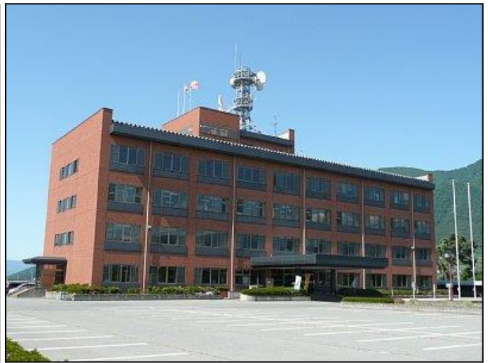
北信合同庁舎外観
