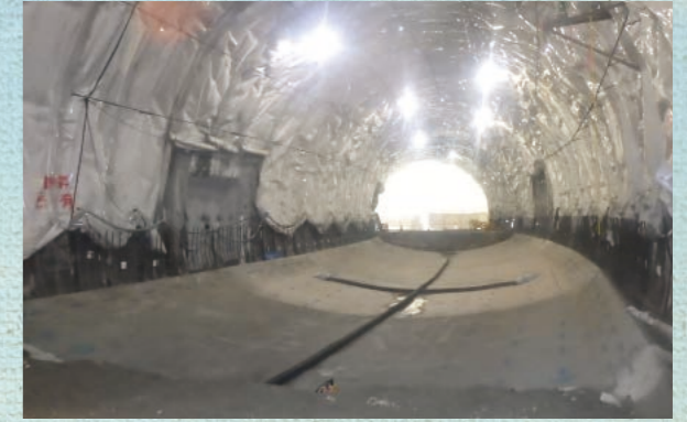
■ インバートコンクリート打設
