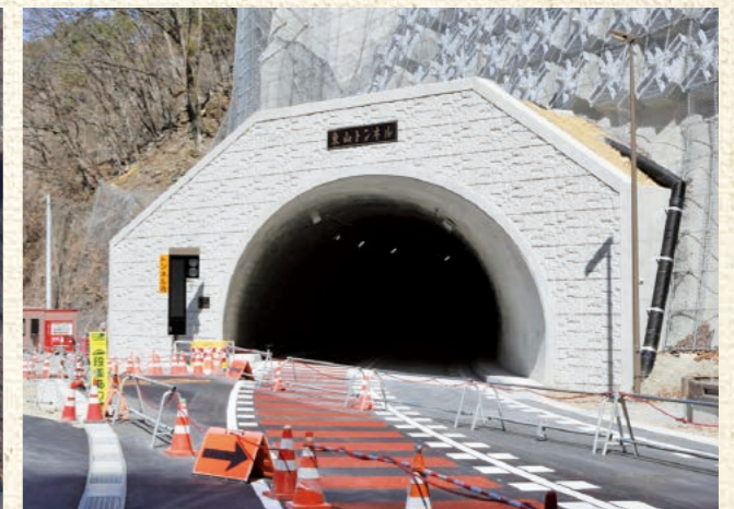
東山トンネル大鹿側入り口
