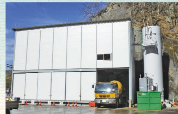
■ バッチャープラント
