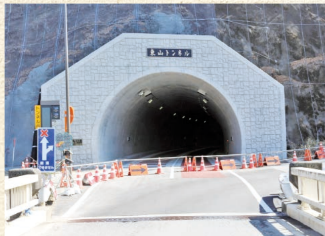
東山トンネル松川側入り口
