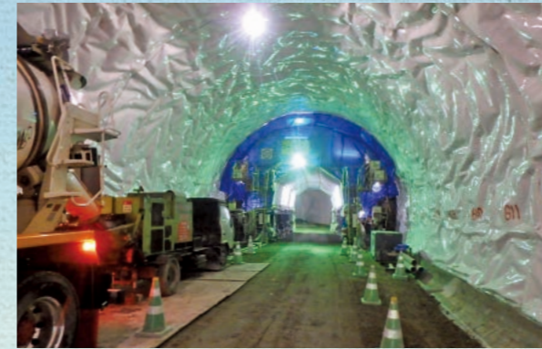
■ 覆工コンクリート打設
