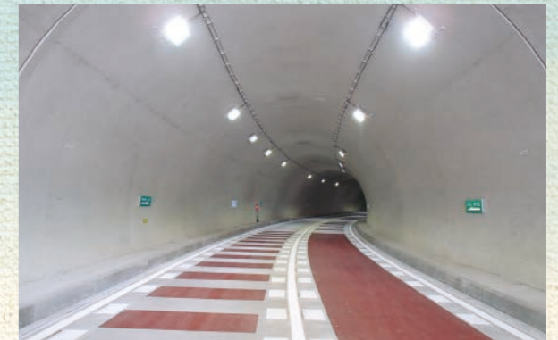
■ トンネル内部
