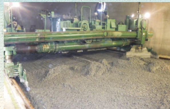
■ コンクリート舗装
