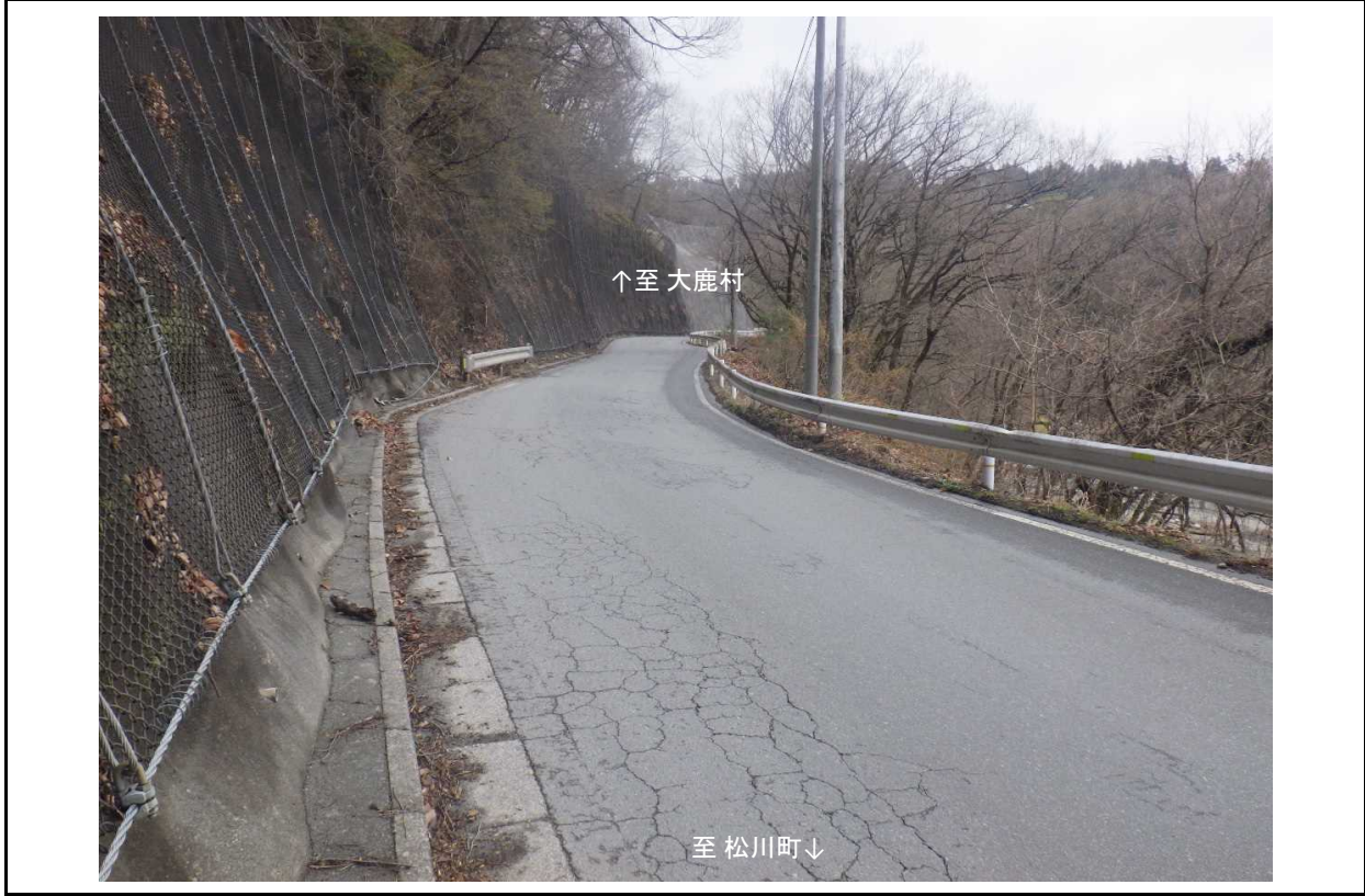
工事前 道路状況 (松川町側から大鹿村方面を望む)
