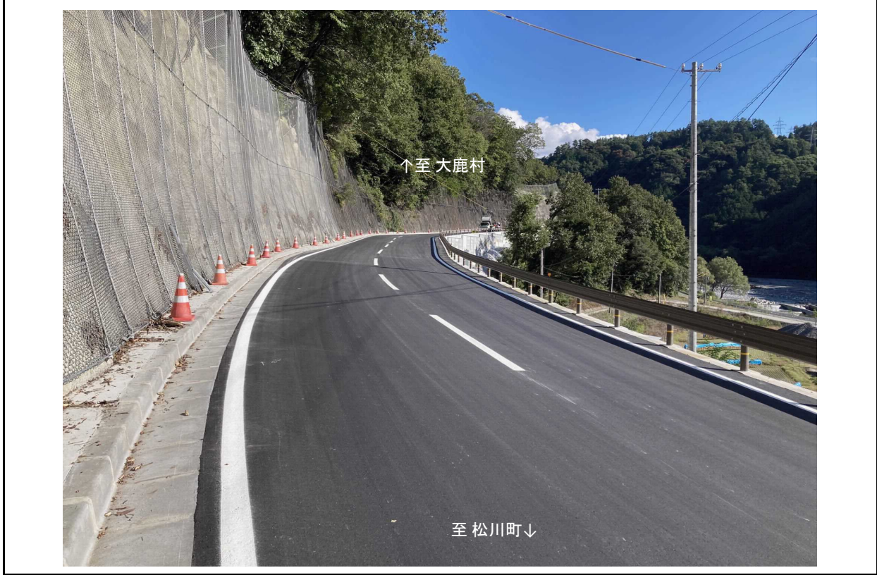
工事後 道路状況 (松川町側から大鹿村方面を望む)
