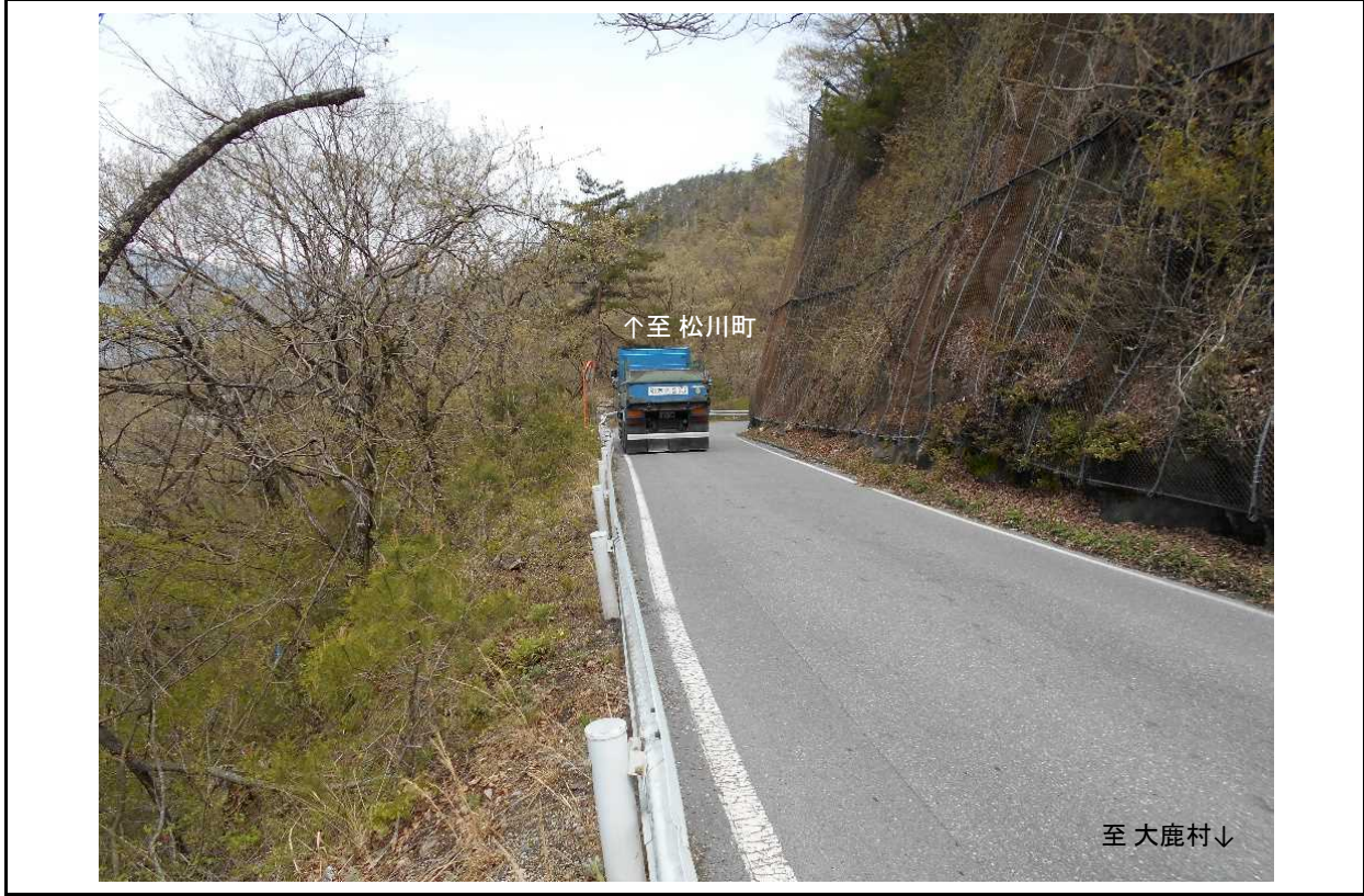
工事前 道路状況 (大鹿村側から松川町方面を望む)
