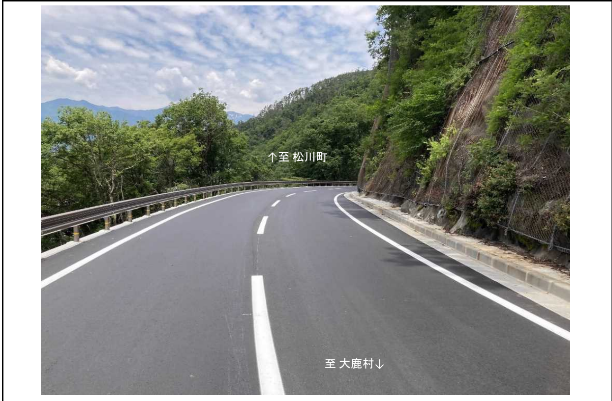
工事後 道路状況 (大鹿村側から松川町方面を望む)
