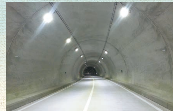
■ トンネル内部
