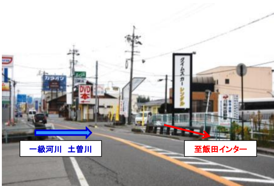
一級河川 土曾川 橋梁
