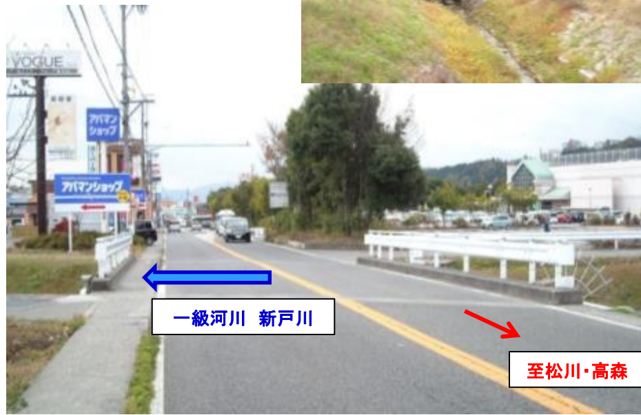
一級河川 新戸川 橋梁
