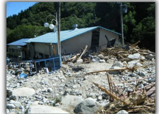
【H25 被災状況】
