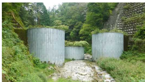
門原1号砂防ダム
