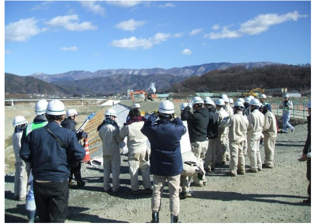
【盛土工事が進む現場】
