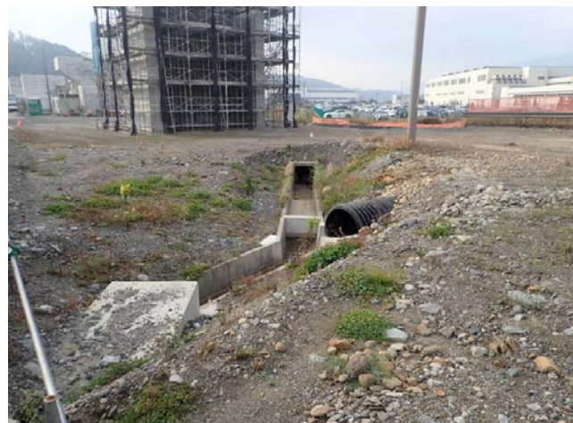
水路工施工箇所
