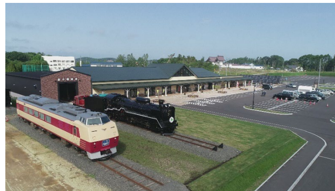
〈道の駅あびらD51ステーション〉
