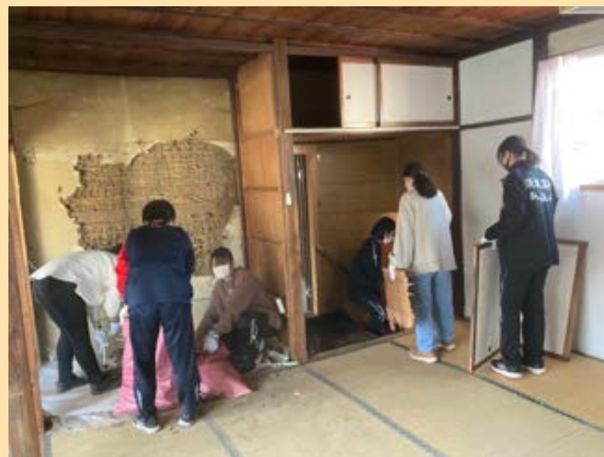
古民家を解体開始
