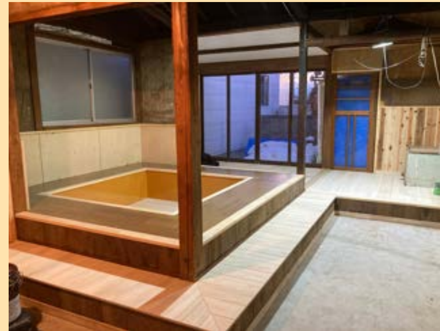
内装改修工事
