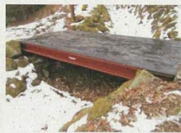
セラピー基地等施設整備支援 ：佐久市（歩道補修）
