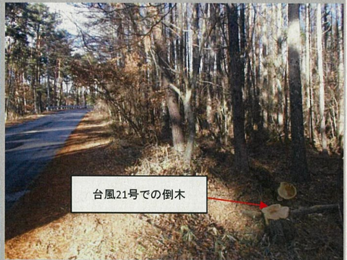
現場では既に倒木が発生しており、倒木のおそれがある立木が残存していることから、これらの危険木の除去を行う
