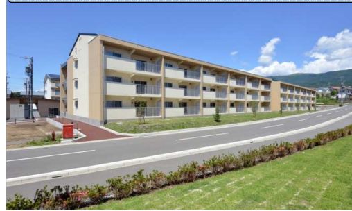
《H23~25建設 君石団地(塩尻市)》
