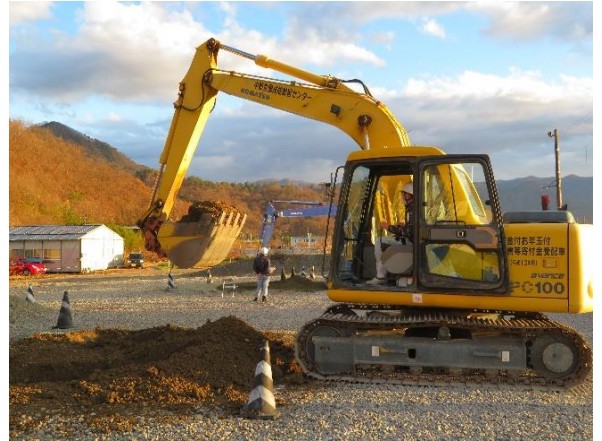
12月 バックホー運転技能研修
