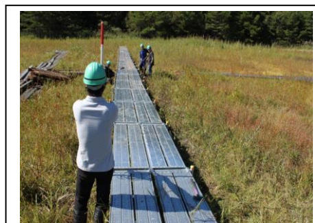
【歩道改修工事】
