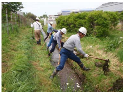
※ 農業用排水路の泥上げ作業（伊那市）
