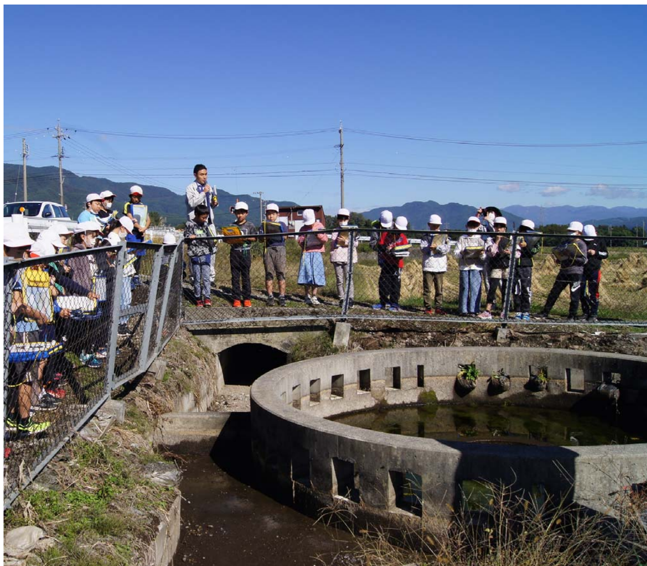
次世代を担う子供たちに農業資産「円筒分水工」の仕組みを説明
