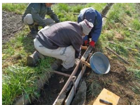
※ 水路の補修（箕輪町）
