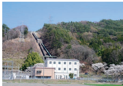
春近発電所 (現在改修工事中)
