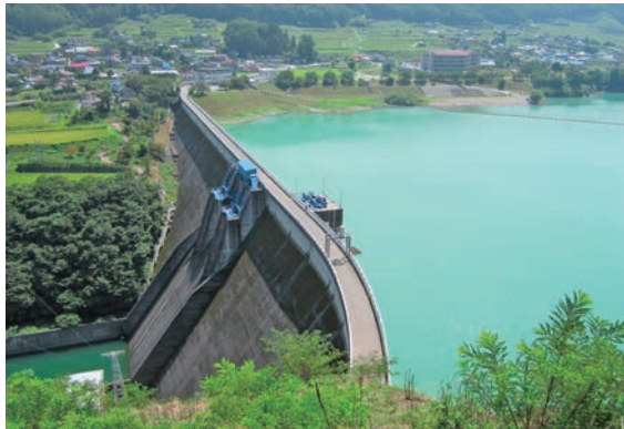
美和ダム (旧建設省施工、昭和32年完成)
