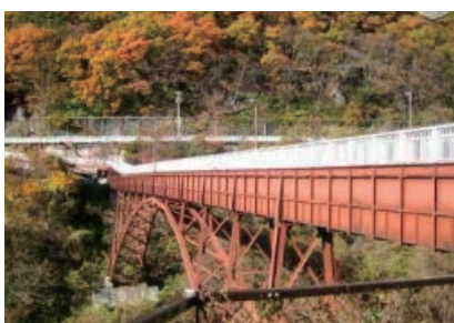
① 右岸へ渡る水路橋「虹橋」
