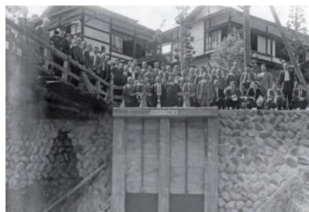
みすず隧道 取入口（春日健氏 提供）
