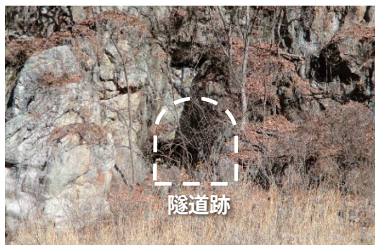
現在も残る二番井の隧道跡（高遠ダム下流）
