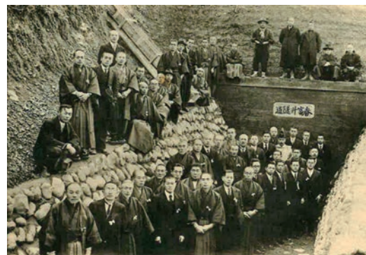
春富井隧道完成時の様子 (春富土地改良区提供 昭和12年)
