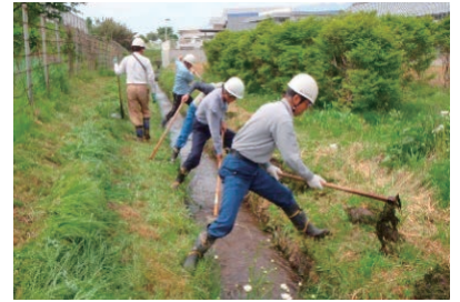
水路の泥上げ作業
