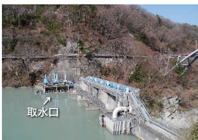
⑦ 高遠ダム取水口
