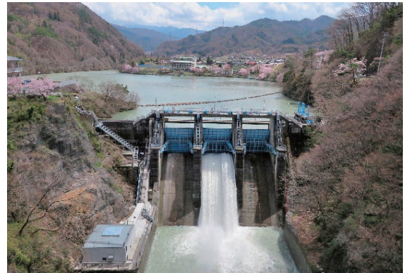
高遠ダム (長野県施工、昭和33年完成)
