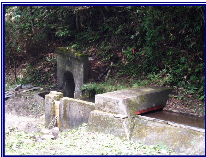
トンネル入口の水柵
