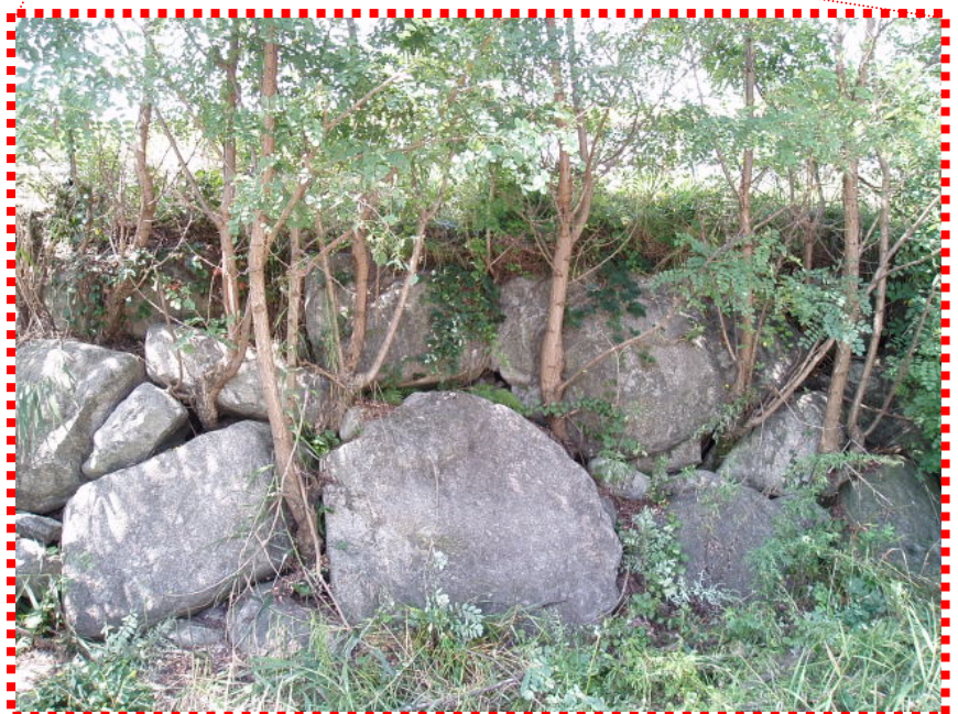
石積みによる堤防
