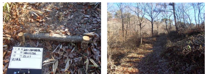
森林公園遊歩道及び周辺林整備 (大桑村)
