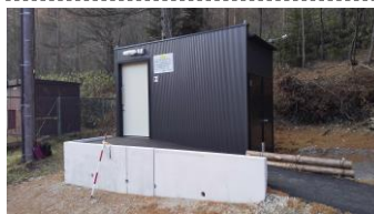
セラピー基地等施設整備支援▼▶ 阿智村 (バイオマストイレ整備)
