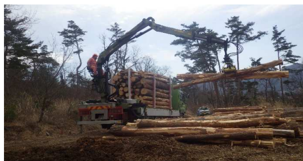
枯損木の搬出状況
