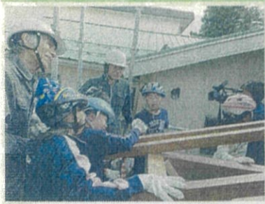
大人に教えてもらいながら材木を組み上げる
