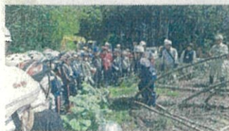
木の伐採現場で作業を体験
