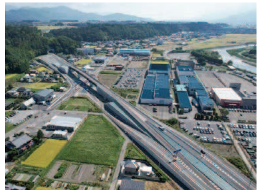
国道153号伊那バイパス
