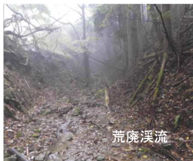
施工状況 (飯島町山ノ田)
