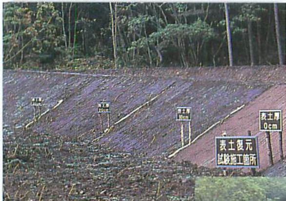
Restoring topsoil and vegetation at the 10th corner of Route 292 (Shiga Route), 1995 国道292号第10号カーブ (志賀ルート) 1995年
