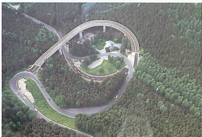
Improvement and construction of the Olympic road (Shiga Route) オリンピック道路の整備(志賀ルート)
