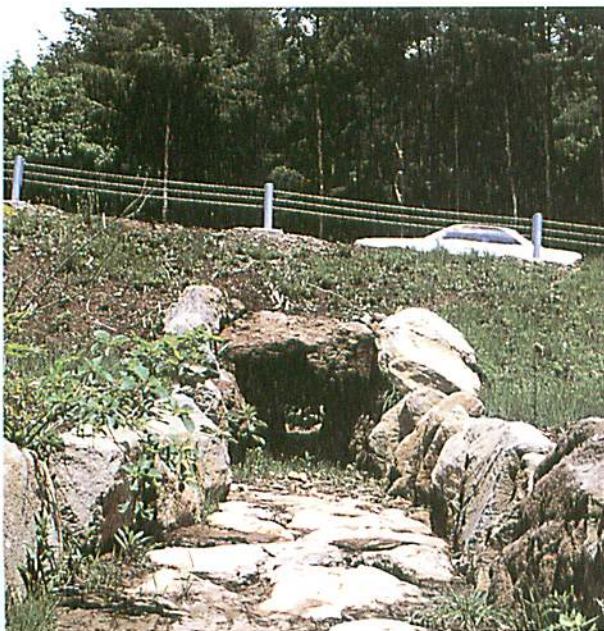
Under-path allowing the free passage of animals (Shiga Route) 動物移動経路（エコロード）の設置（志賀ルート）
