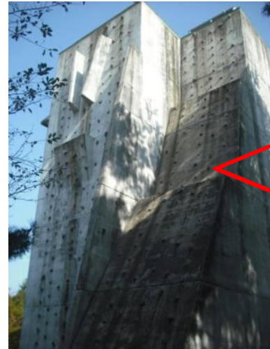
使用するテラス
