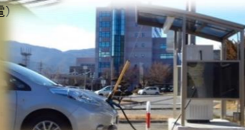
(EVと充電設備)
