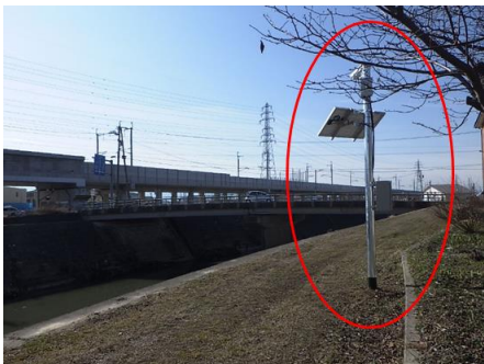
簡易型河川カメラの設置
