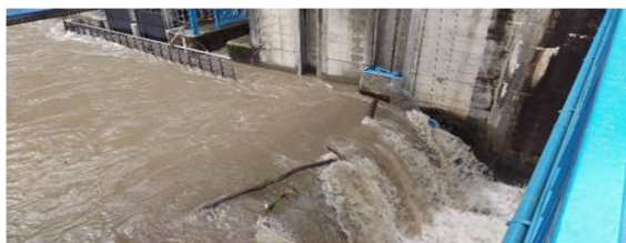
図21 流木と濁度上昇時の取水口
