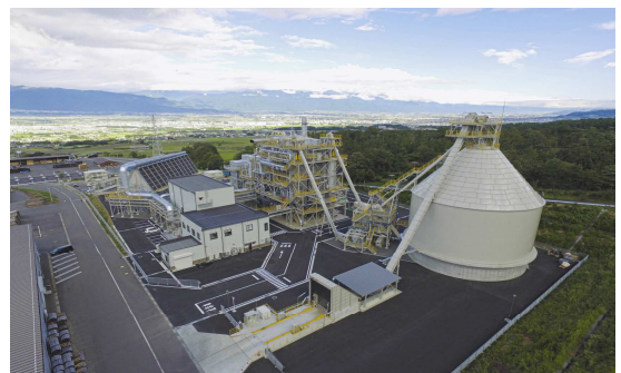
信州F・POWERプロジェクトの木質バイオマス発電所
