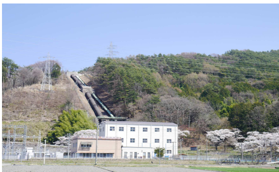
長野県企業局の春近水力発電所
