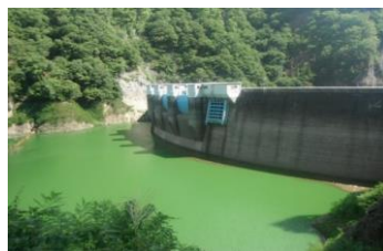
ダム湖で増殖した植物プランクトン
