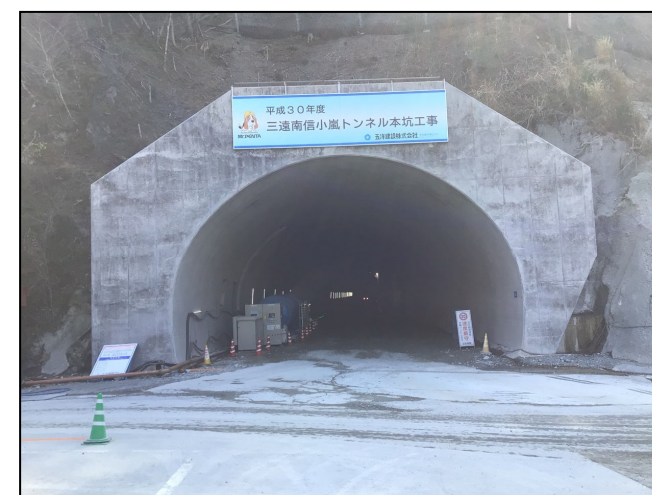
②トンネル本坑坑口
