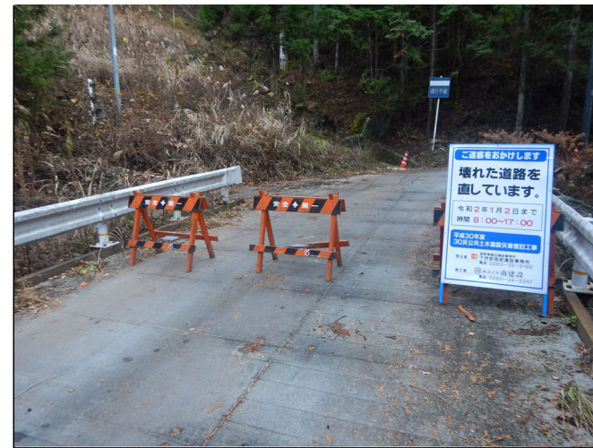
工事現場への立ち入り禁止柵
