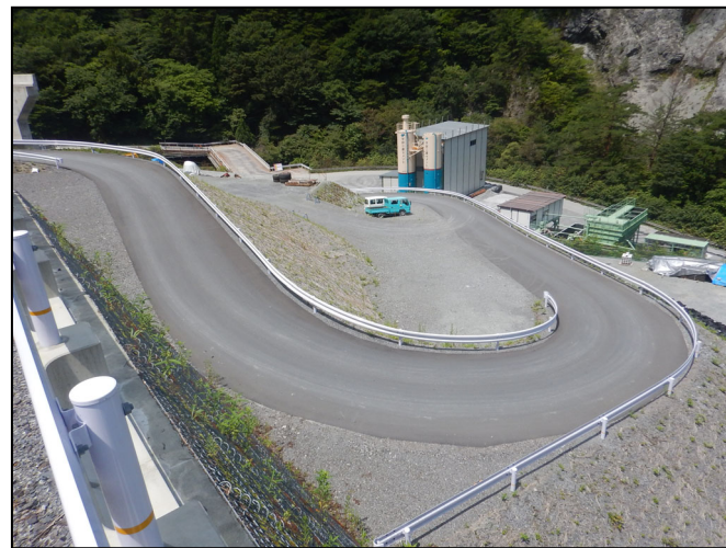
工所用道路の仮舗装
